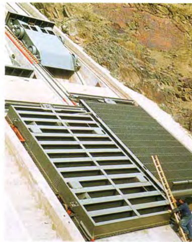
Grundablaß-Einlauf mit Notverschlüssen, Einlaufrechen und Betriebsverschluß
