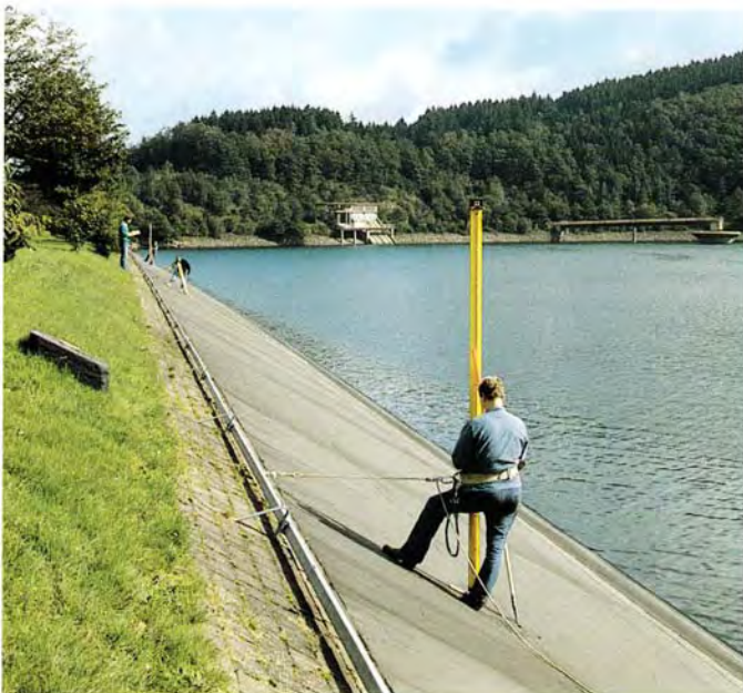
Die Bauwerke werden regelmäßig meßtechnisch überwacht
