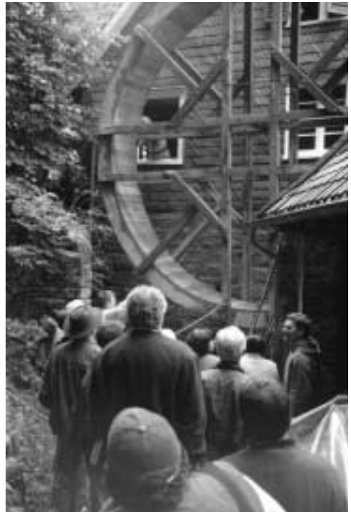
Einbau des neuen Mühlrades
