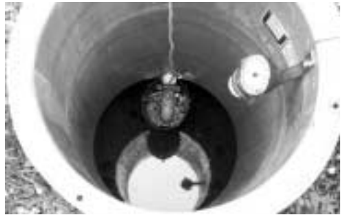
Abb. 17: Blick in den Gelbwasserspeicher
