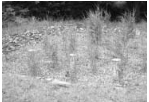
Abb. 15: Fertiggestellter bewachsener Bodenfilter in Betrieb
