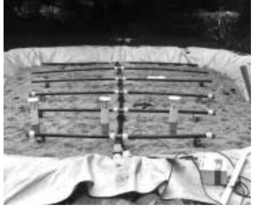
Abb. 14: Verteilungsgerinne des bewachsenen Bodenfilters (in Bau)
