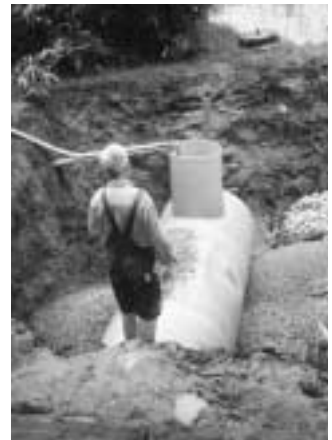
Abb. 12: Einbau des Gelbwasserspeichers aus GFK
