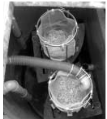
Abb. 21: Rottesäcke mit Behälter vor und nach dem Einbau
