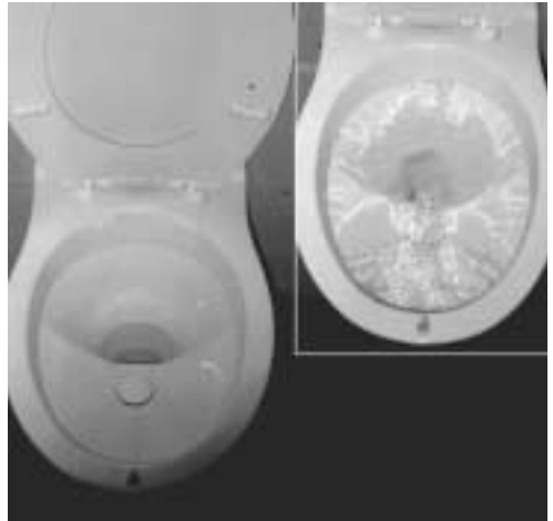
Abb. 7: Separationstoilette der Fa. Roediger - Einsatz des Prototyp in der Lambertsmühle
