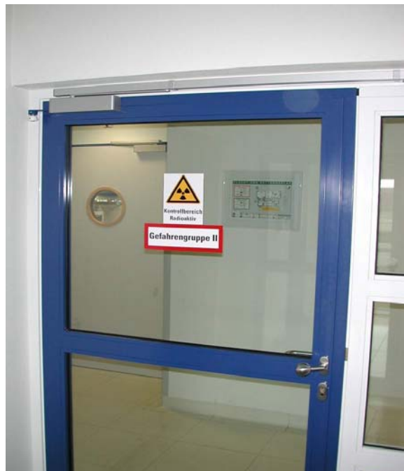
Abb. 2.3: Zugang zu einem Kontrollbereich
