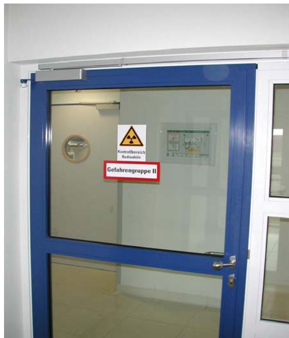
Abb. 2.3: Zugang zu einem Kontrollbereich
