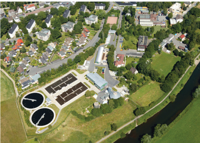
Abbildung 03-1: Aufsicht auf die Kläranlage Schwerte (Quelle: Fotoarchiv Ruhrverband)
