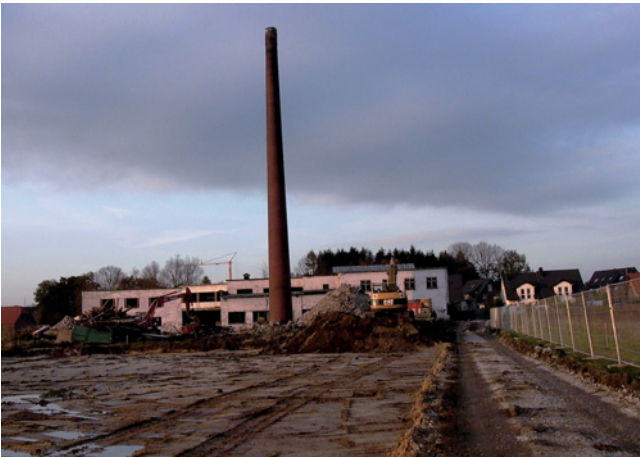
Abbildung 05-5: Die Gebäude einer ehemaligen Gerberei in Halle (Westfalen) kurz vor dem Abriss (Quelle: AAV)
