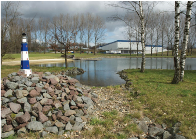
Abbildung 5.4-2: Naturnah gestaltetes Regenbecken auf dem Gelände der Firma Dewender
