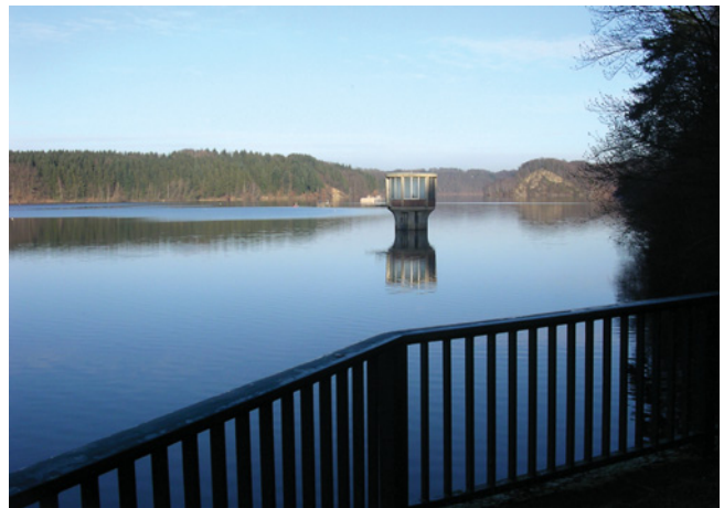
Abbildung 06-1: Entnahmeturm einer Trinkwassertalsperre
