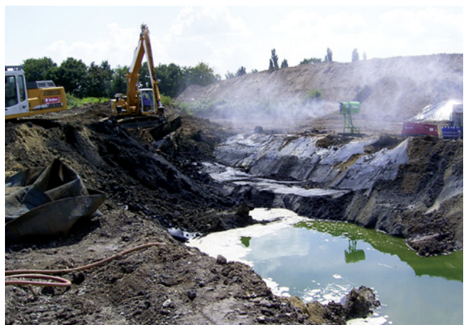
Abbildung 05-4: Mit Sprühnebelkanonen wurden auf dem ECF-Gelände in Kempen beim Ausheben der Halden Geruchsemissionen bekämpft (Quelle: AAV)
