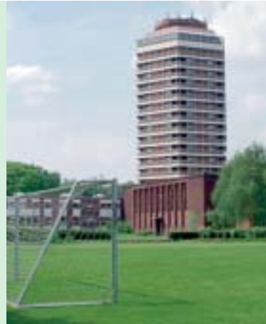
Die Sportschule des Fußballverbandes Niederrhein e.V. in Duisburg-Wedau. Hier werden die rund 250 teilnehmenden Fußballer untergebracht.
