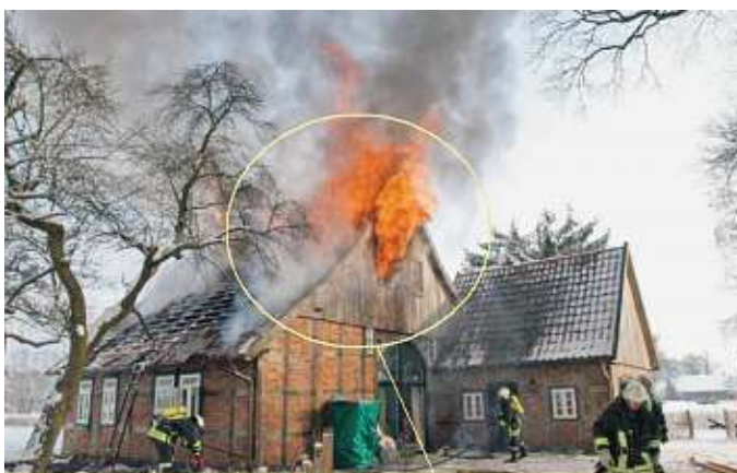
...die offenen Flammen aus dem Dachbereich erkennbar sind! Der Brand ist übrigens in der Elektroleitung zum Dachbereich, die an der Fußfette verlegt war, entstanden.
