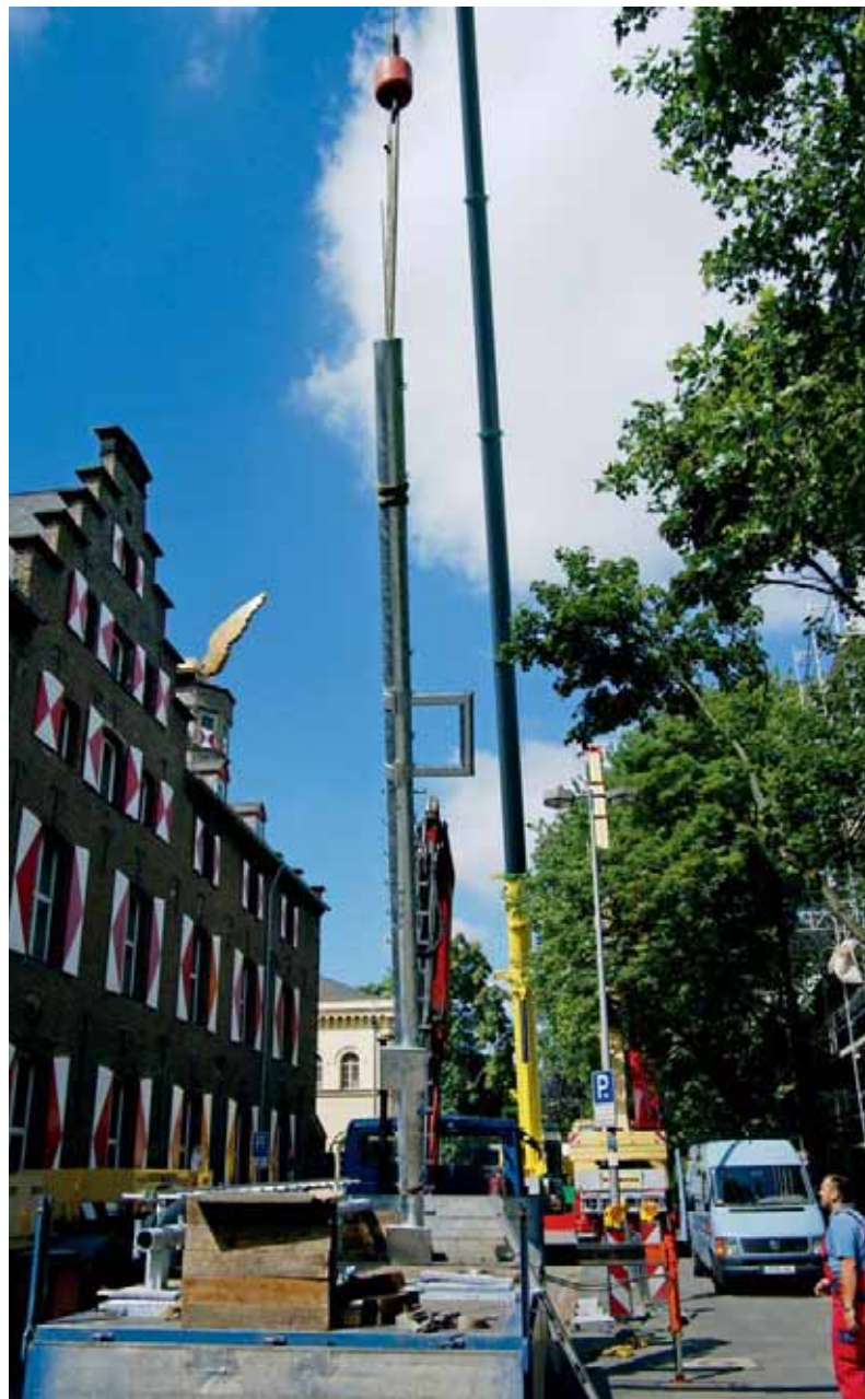
Aufstellung eines Antennenmastes auf dem Dach der Bezirksregierung Köln Ende Juli 2008. Foto: Projektgruppe
