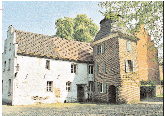
Der Torturm an der Stiftsgasse diente früher als befestigter Zugang zum Stift.
