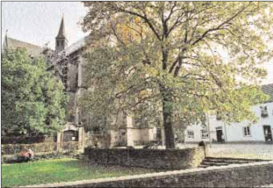
Der mächtige Kirchenbau wird momentan saniert.
