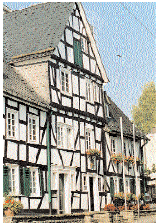
Im Amtshaus (Altes Rathaus) saß ursprünglich der nassauische Amtmann und Schultheiß.
