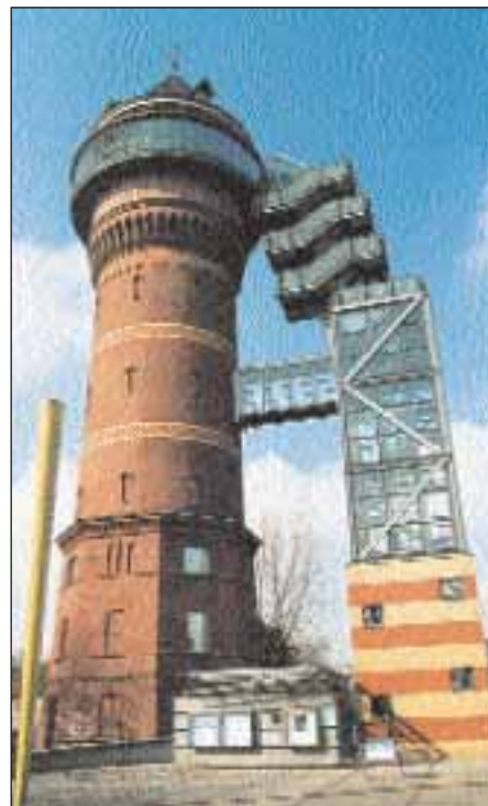
Die kühne Stahlträgerkonstruktion (1992) schaffte im Wasserturm (1892) Platz für das Wassermuseum Aquarius.
