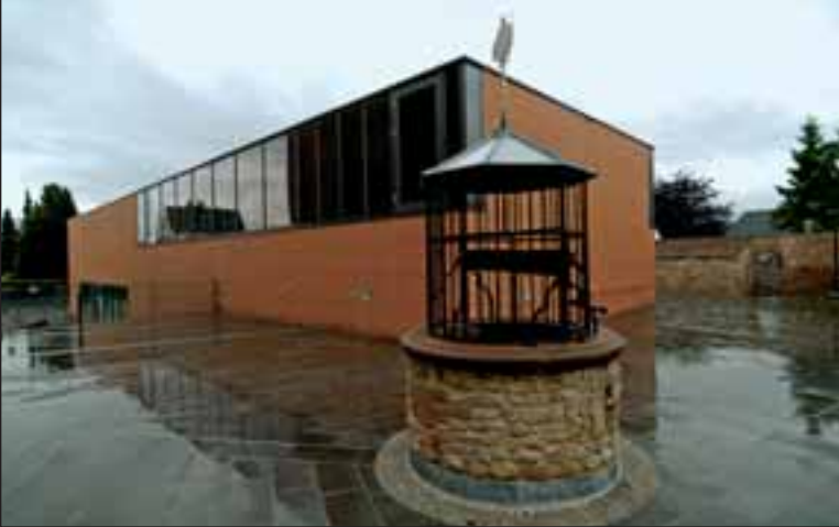
Der Quirinus-Brunnen, um 1130 dem Schutzpatron der Pferde gewidmet, wurde im Zuge der Neugestaltung generalüberholt. Als die Mönche im Mittelalter auf der Freifläche des Platzes den Brunnen anlegten, ahnten sie nicht, dass sie römischen Baugrund durchstießen.
