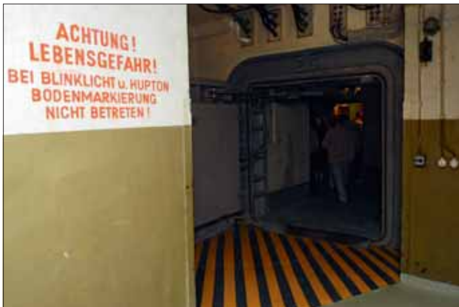
Tonnenschwere, 1,5 Meter dicke doppelte Betontore verschlossen den Eingangsbereich, dahinter sollten fast ebenso gigantische Stahltore Hitze, Druck und Erschütterungen endgültig abhalten.
