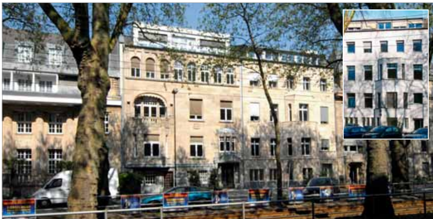
Harmonisches Gesamtbild: Die Marmorplattenverkleidung (kleines Foto) des KZV-Gebäudes auf der Lindemannstraße 38 in Düsseldorf, die aus sicherheitstechnischen Gründen erneuert werden musste, ist einer zu den Nachbarhäusern passenden Sandsteinfassade gewichen.
