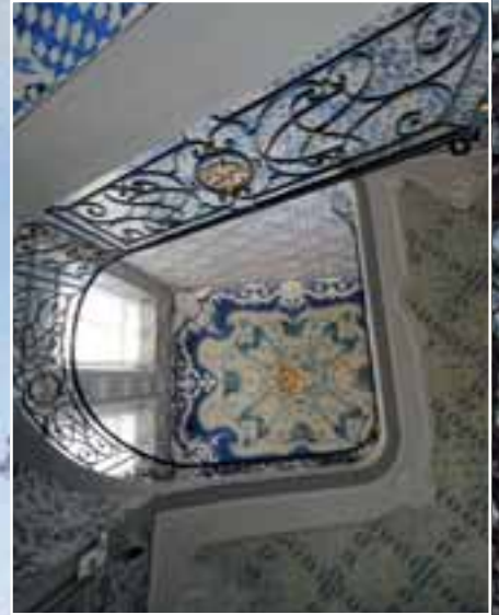
Der Weg in die obere Etage führt durch das prunkvolle Treppenhaus mit fast 10000 Fliesen. Auf edler Keramik sind Motive wie Falken, Reiter, Hofdamen und Reiher in blauer Farbe festgehalten.
