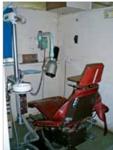
Das Dental Department des Vaiola Hospitals besteht neben einem Warteraum und einem Labor aus mehreren Räumen mit zum Teil veralteten Behandlungseinheiten.
