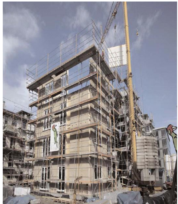
Bild 27 Mehrgeschossiger Holzbau, Bauphase [Foto: Fermacell GmbH, Duisburg]
