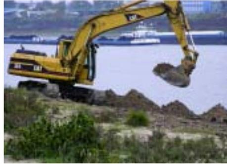
Bagger beim Entfernen der Uferbefestigung
