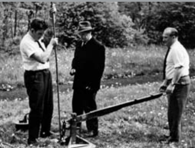
Sondierbohrung für ein ingenieurgeologisches Gutachten
