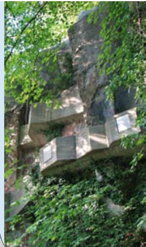
Felsanker und Stahl- beton stützen den Drachenfels.
