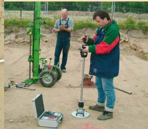
Verdichtungsprüfung mittels Rammsonde und dynamischem Plattendruckversuch
