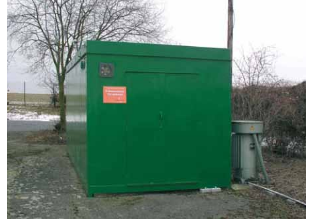
Seismikstation des GD NRW bei Jackerath
