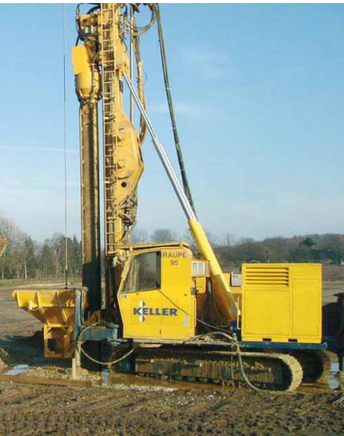
Befüllen des Schleusenrüttlers mit Kies
