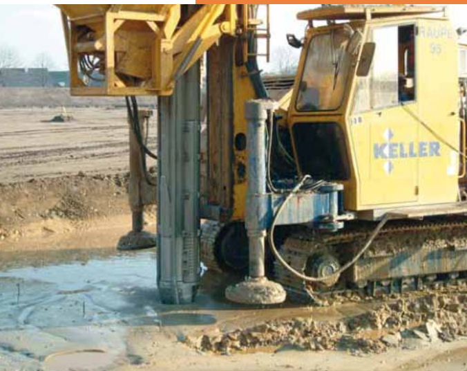
Absenken des Schleusenrüttlers
