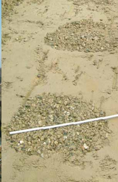
Stopfsäulen von ca. 60 cm Durchmesser
