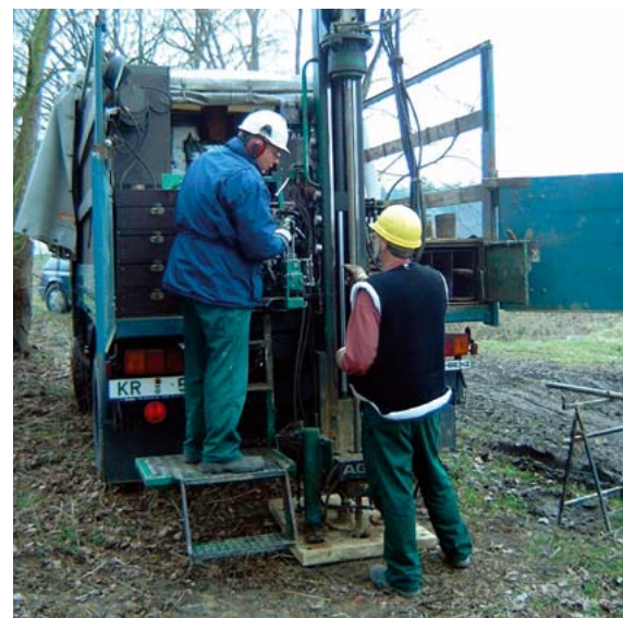
Erkundung des Untergrundes mit Sondierbohrungen
