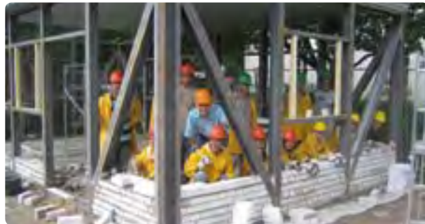
Iranische Studierende lernen im Rahmen einer Summer School den Bau eines erdbebensicheren Hauses.
