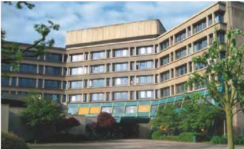
Haus I der Bundesanstalt für Arbeitsschutz und Arbeitsmedizin (BAuA) in Dortmund
