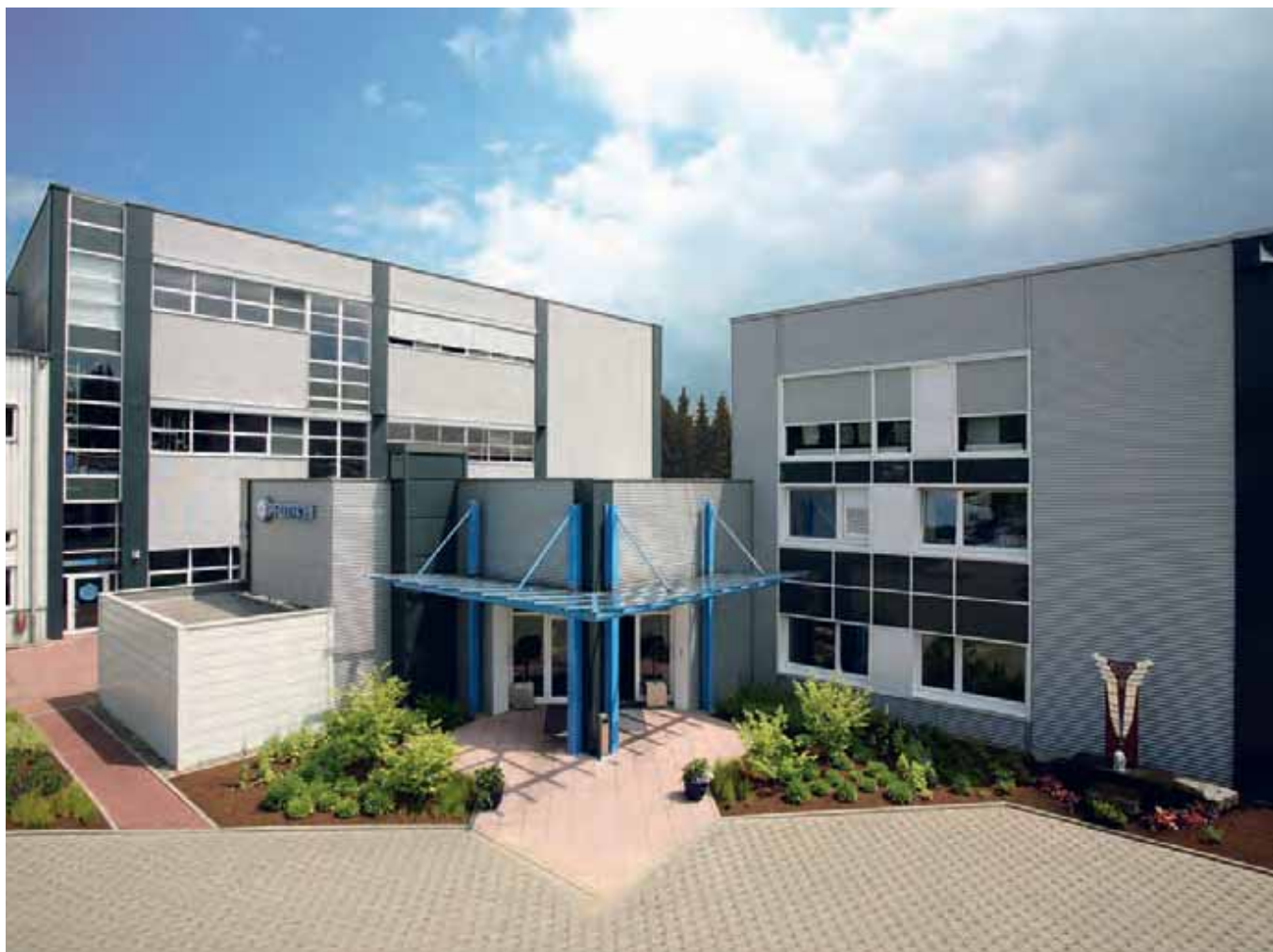
Verwaltungsgebäude der Pflitsch GmbH & Co. KG, Hückeswagen
