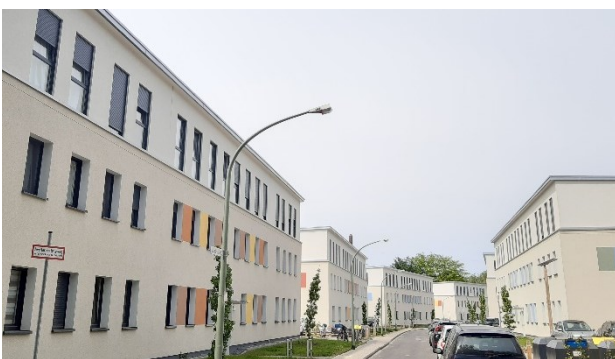
Neuer Wohnraum durch Dachgeschossaufstockungen im sogenannten „Hüttenheim Carrée“
