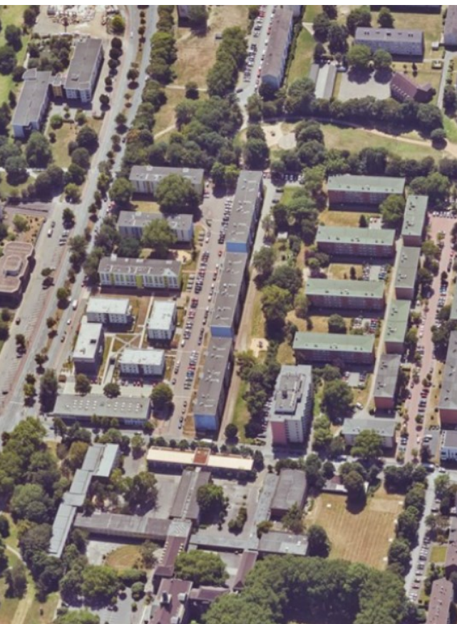
Siedlungsbestände und Ersatzneubau in Rheinhausen-Mitte (© RVR Luftbild 2023)
