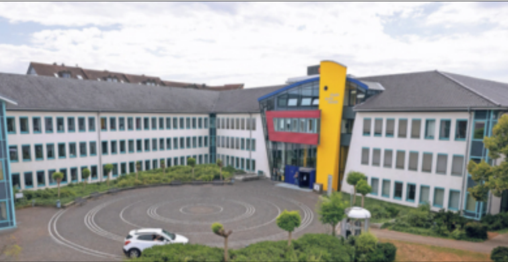
Das Kreishaus in Grevenbroich – ein moderner, stolzer Bau. Kleines Bild unten: Kreissprecher Benjamin Josephs informiert über die Arbeit des Rhein-Kreises.
