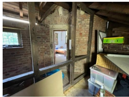
Im Hintergrund die Kemenate nach Entfernung der Glaswand
