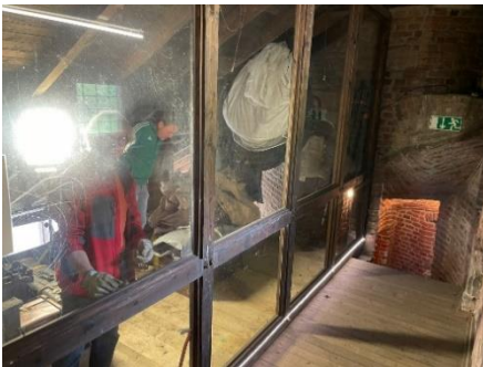
Demontage der Glaswand
