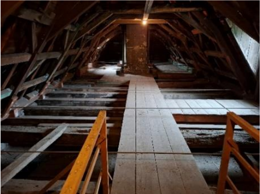
Der Dachstuhl des Herrenhauses
