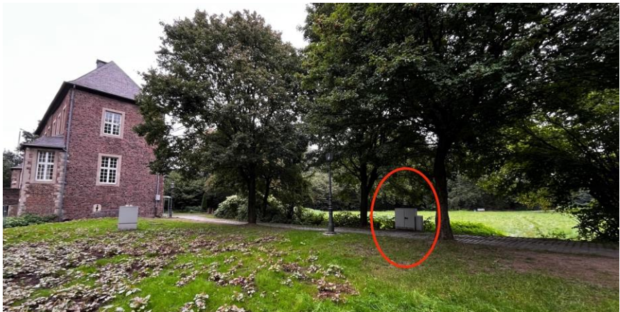
Mess- und Stromversorgungsschrank Ostwiese
