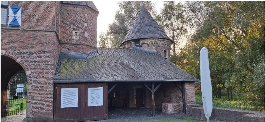
Der alte Wehrgang zwischen Torzimmer und nördlichem Turm ist heute verdeckt durch das Dach der alten Stallung. Gut erkennbar im Mauerwerk des Turms ist der ehemalige Zugang zum Burghof.
