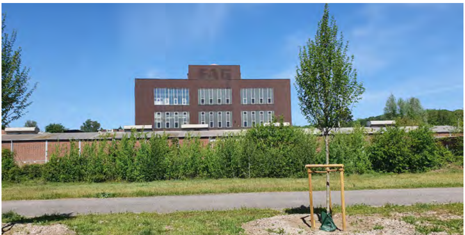
Blick von der Nordbahntrasse auf das ehemalige Kugelfischer/Schaeffler-Areal.
