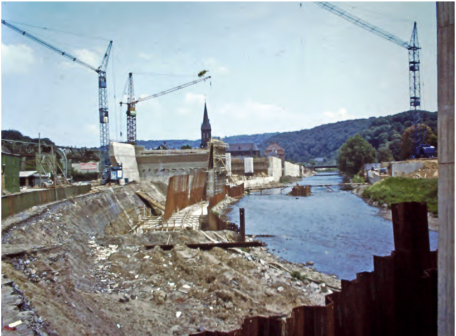
Verlegung der Wupper
