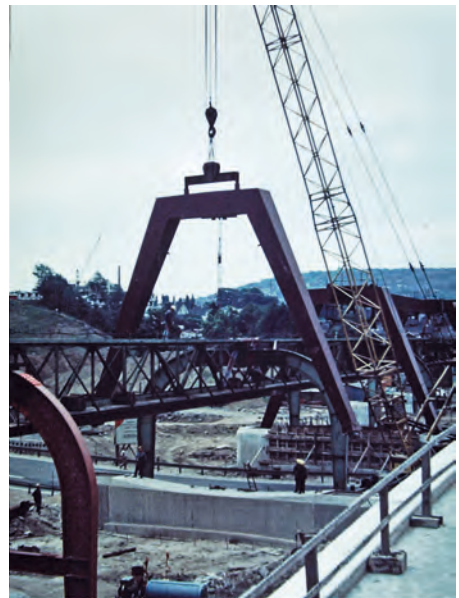
Einsetzen der gegossenen Sonderstützen
