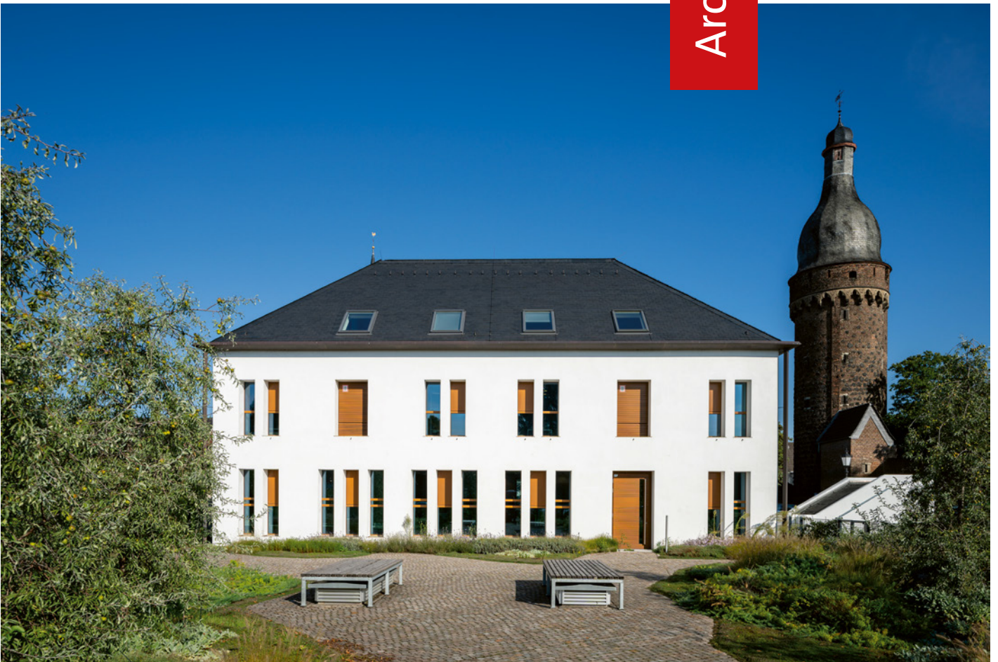
Archivgebäude von hinten, Foto: Patrick Gawandtka
