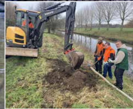
Typisches Gehölz befestigt die Ufer der Niers, schafft neuen Wohnraum für Tiere und ein besseres Klima im Gewässer.
