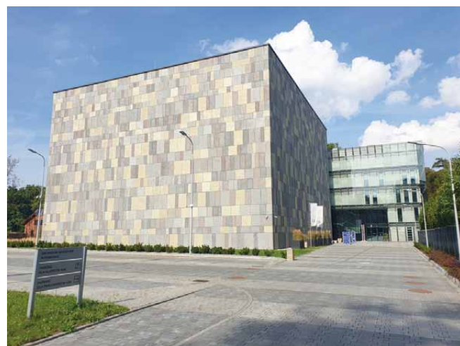
Das neue Nationalarchiv in Krakau von Süden, links der Magazinbau, rechts das Verwaltungsgebäude (Foto: Rainer Jedlitschka)
