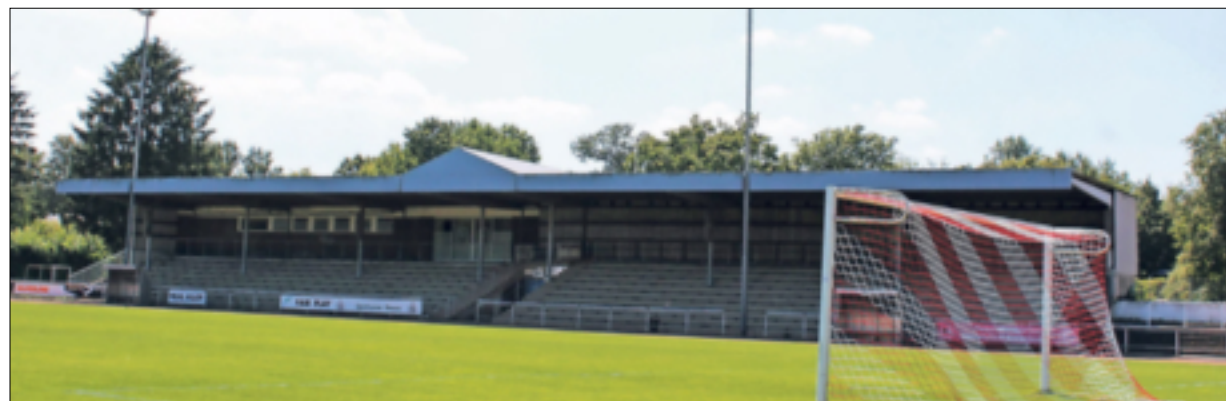
Eine „neue Zukunft“ für das Schloss-Stadion im Blick: Ziel ist die Schaffung einer Mehrgenerationen-Multifunktionsportstätte, die eine ganzjährige Nutzung für die ansässigen Vereine und auch die weiteren Institutionen ermöglicht. Das Entwicklungskonzept sieht unter anderem die Errichtung eines Kunststoffrasen-Großspielfeldes
