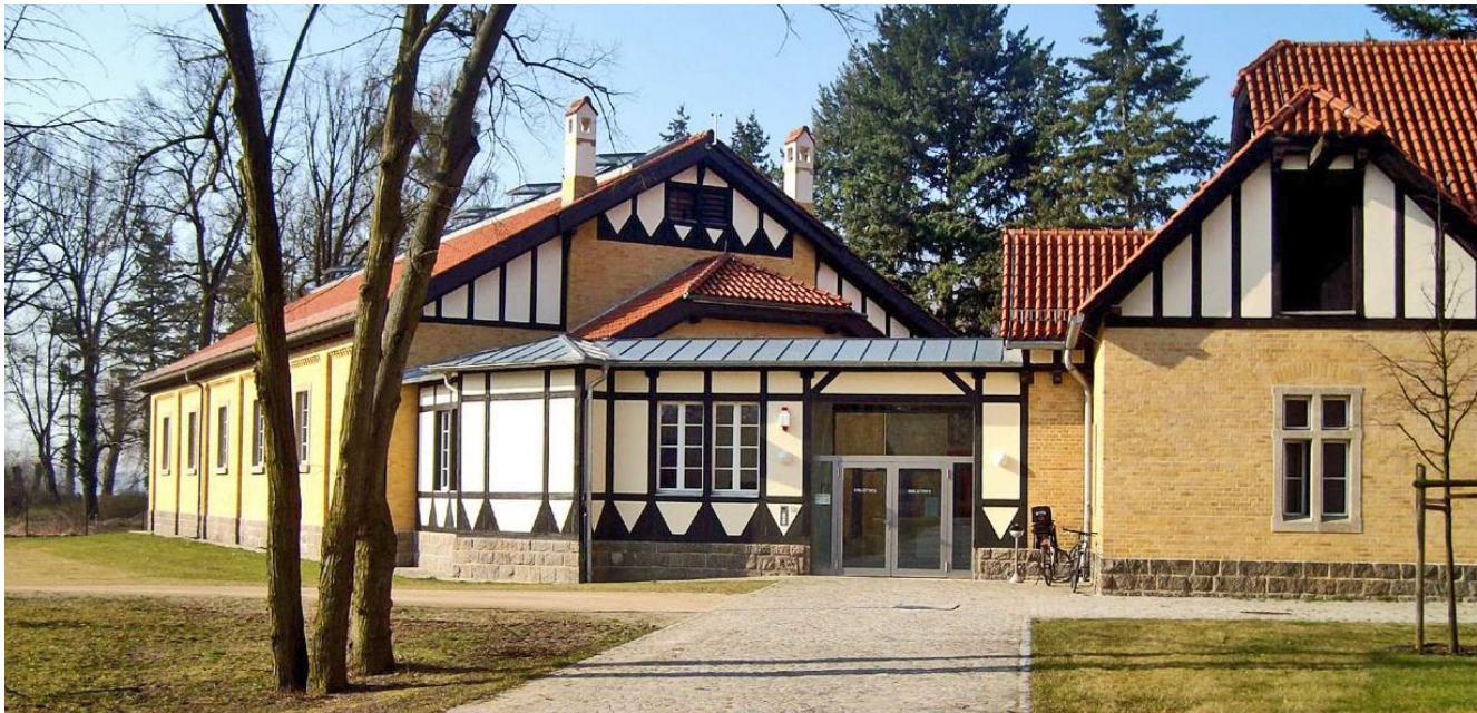
Gebäude des Militärgeschichtlichen Forschungsamtes
