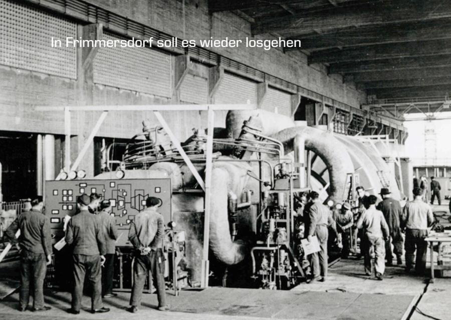
„Industrielle Revolution“ a la Frimmersdorf: Dieses Bild der Turbine aus Block E stellte das RWE zur Verfügung.
