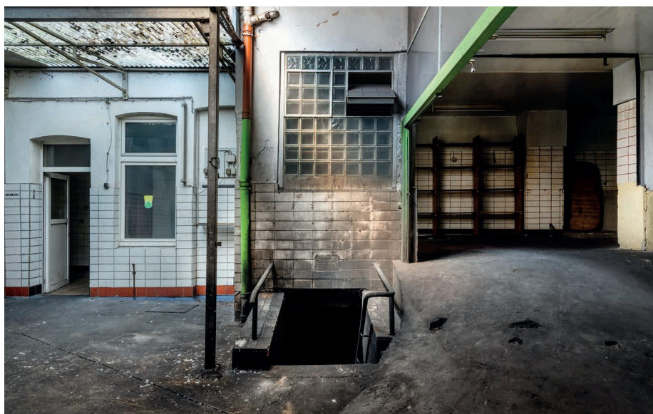
Die ursprünglichen Eigentümer haben in dem Gebäude über Jahrzehnte eine Fleischerei betrieben
