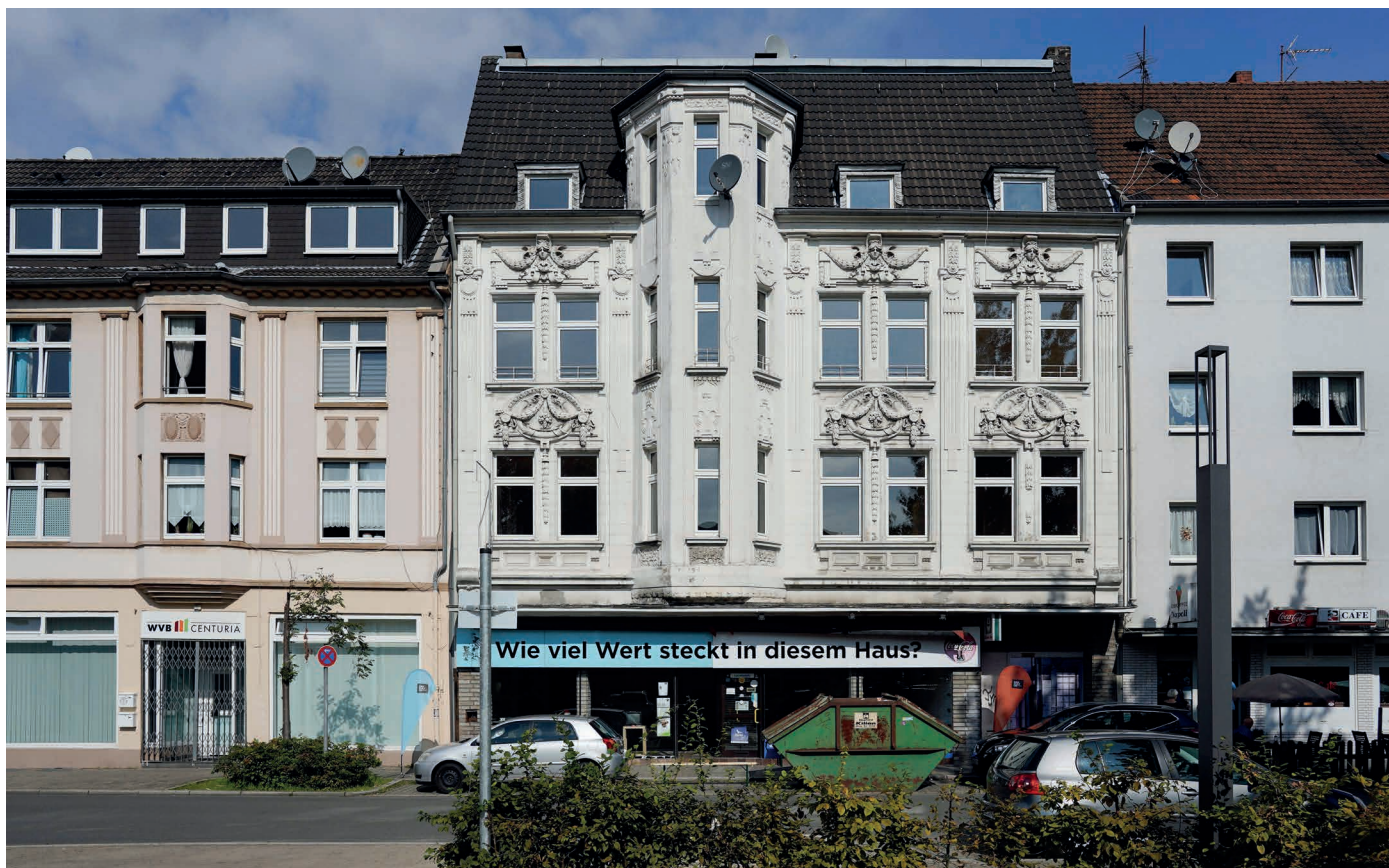
Das Gebäude des UmBauLabors in der Bergmannstraße 23 in Gelsenkirchen-Ückendorf
