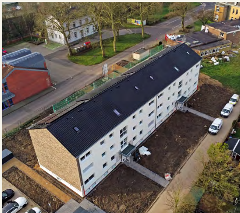
Wohngebäude nach KfW-Standard EH70 saniert
