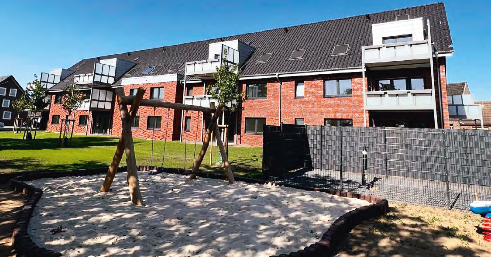
Neubau in St. Hubert mit 20 frei finanzierten Wohneinheiten
