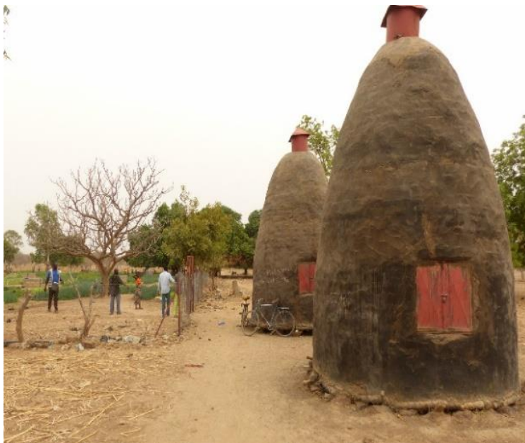
Abb. 4: Speichergebäude für Zwiebeln.
