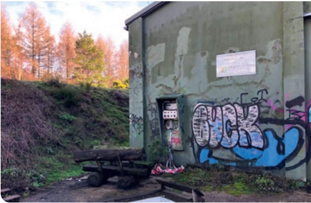
Vereinzelt stehen noch Gebäude, die sich wahrscheinlich irgendwann in Ruinen verwandeln werden. Die meisten Hallen sind aber bereits abgerissen.
