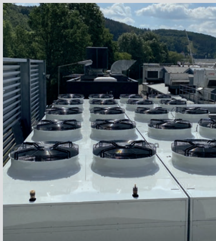
Mit einer Freikühleranlage kann die benötigte Kälte oft zum Nulltarif bezogen werden.
