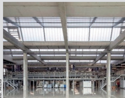
Oberflächenanlage von METZKA
