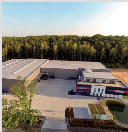
Luftaufnahme des MKV-Standorts in Allersleben
