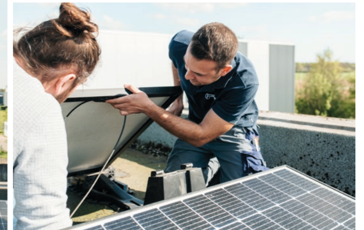
Dachdecker und Elektriker arbeiten Hand in Hand.
