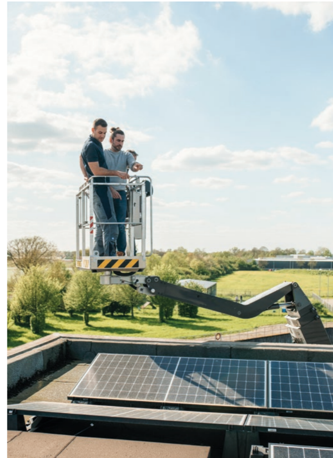
Mit moderner Hubtechnik lassen sich PV-Anlagen besser aufs Dach bringen.
