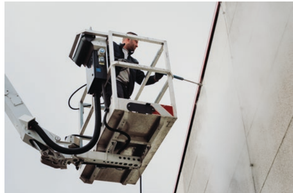
Mit Teleskopplanzen und der fein justierten Mischung aus Wasser und Reinigungsmittel rücken die Fassadenreiniger dem Schmutz zu Leibe.
