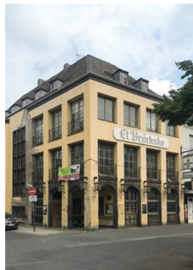
Seit 2009 erinnerte das leerstehende Gebäude schmerzhaft an bessere Zeiten.
