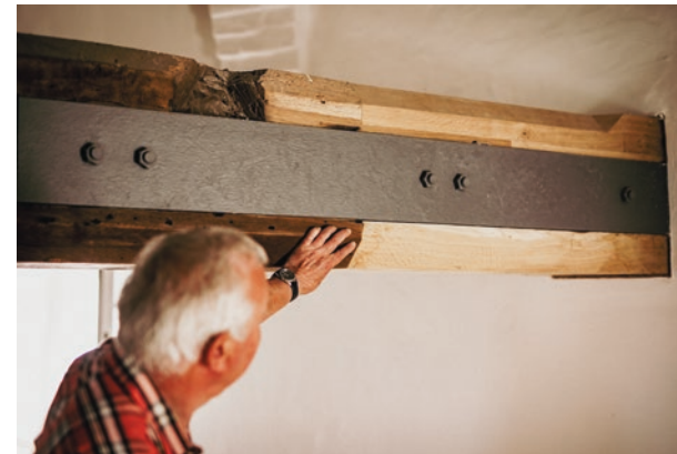
Der zwei Tonnen schwere Königsbalken, das Herzstück der Mühle, war bei der Sanierung eine besondere Herausforderung.
