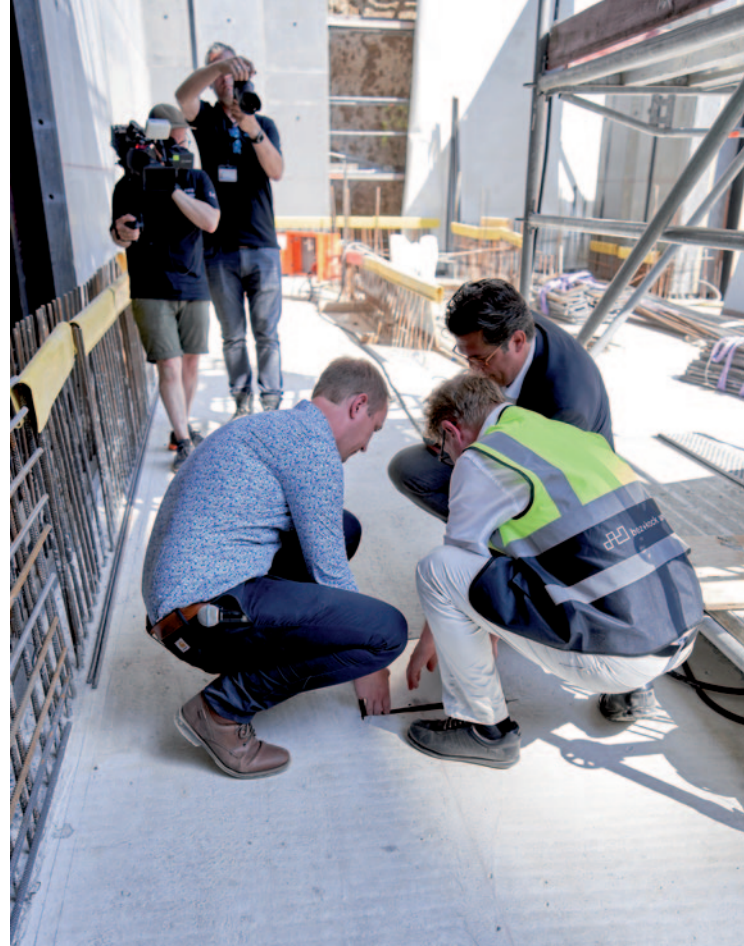
Die frisch versenkte Zeitkapsel in der Bodenplatte des neuen Monheimer Kulturbaus.
