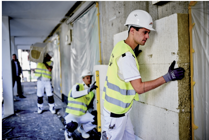
Bei der Außenwanddämmung sind alle tragenden Außenwände und Zwischendecken gut eingepackt. Es dürfen keine sogenannten Wärmebrücken entstehen, deshalb sollte die Dämmschicht möglichst lückenlos um das Gebäude verlegt werden.
