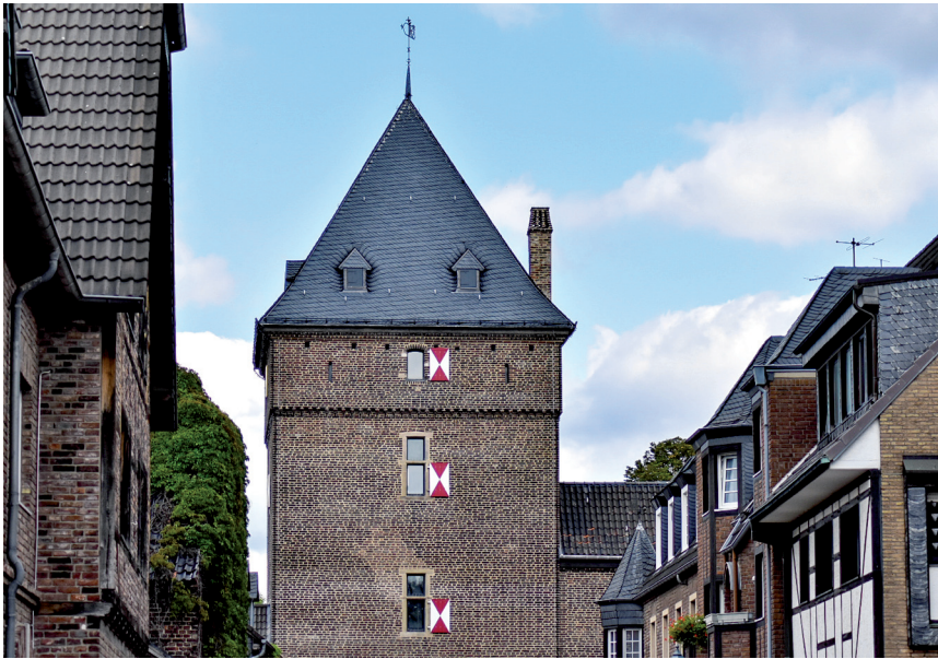
Von der letzten Erneuerung der Monheimer Befestigungsanlagen, ausgeführt um 1425 zum Schutz der Freiheit Monheim, zeugt bis heute der 26 Meter hohe Schelmenturm.
