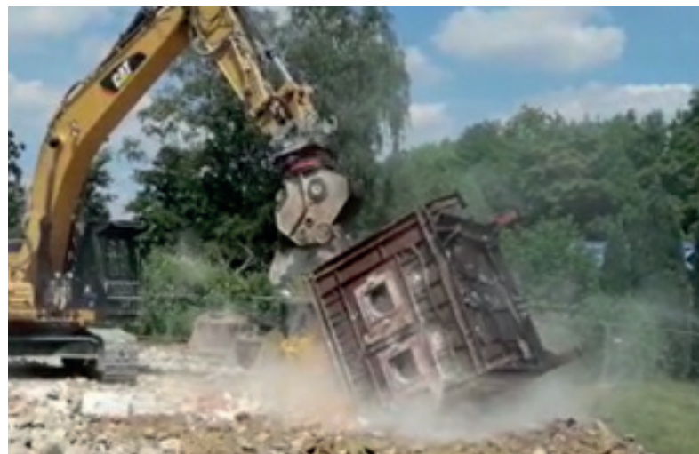
ABBILDUNG 30: ABRISSE UND NEUBAU DES ROTEN OFENS DER IFT
