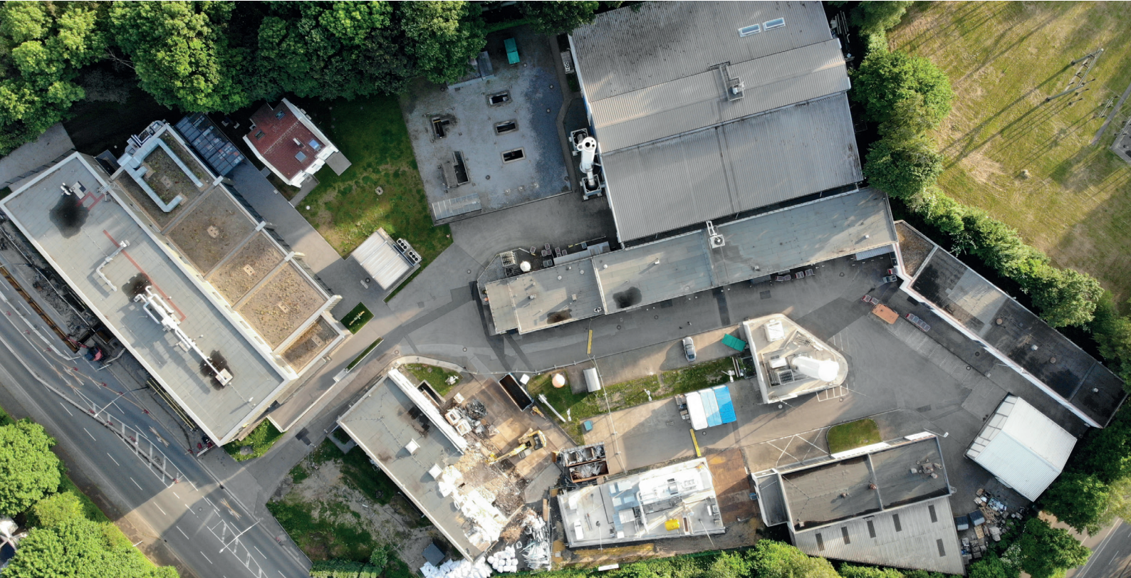
ABBILDUNG 1: BLICK AUF DEN INSTITUTSSTANDORT DES GAS- UND WÄRME-INSTITUT ESSEN E.V.
