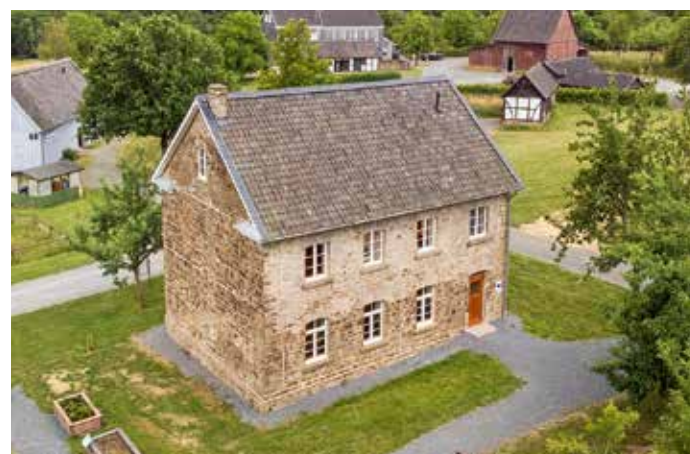
Das Schulgebäude wurde 40 Kilometer vom alten Standort entfernt wieder aufgebaut.
