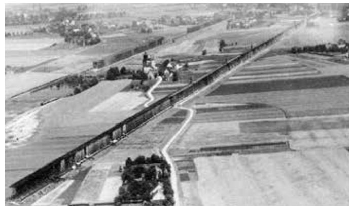
Wie eine Mauer quer durchs Land: Das Gradierwerk „Langer Bau“ in Unna-Königsborn war über einen Kilometer lang. Aufnahme der Firma Junkers-Luftbild von 1927.
