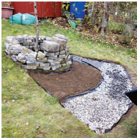
Drainagematerial auf Unkrautvlies
