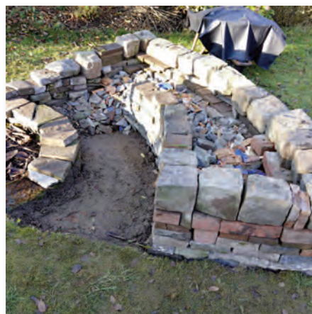
Befüllen mit weiterem Drainagematerial
