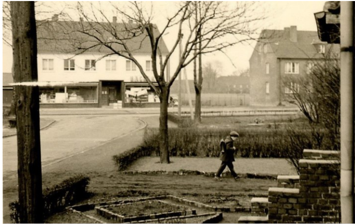
Blick von der Nordstraße auf das neue Geschäftshaus von Wefers/Bormann auf der Jahnstraße, links, um 1962. Der Autor im Vordergrund kommt gerade aus der Schule.
