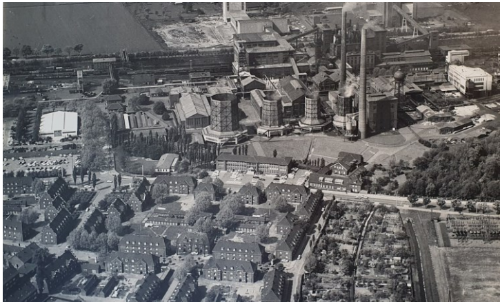
Anlage Niederberg Mitte der 1970er Jahre, im Vordergrund Neue Kolonie mit Schrebergärten
