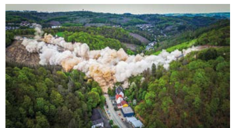
Nachwuchspreis: Sprengung der Rahmedetalbrücke
